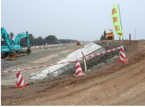
国土交通省による防潮堤建設中 内陸側
