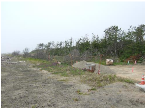
海浜側からみた防潮堤
