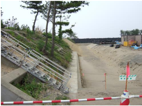
既設治山防潮堤 内陸側
