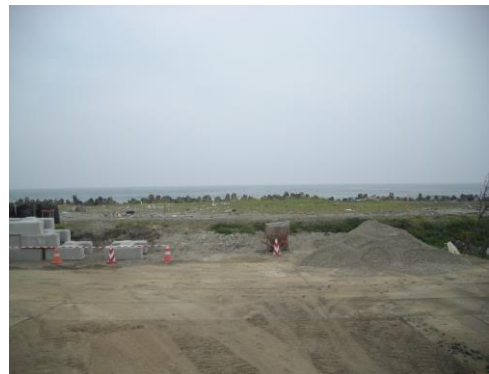
建設中の防潮堤からみた海浜
